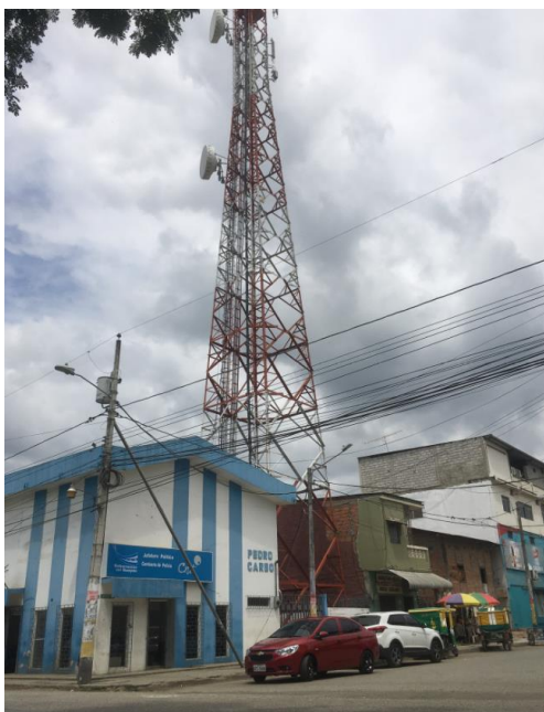
Ilustración 38 Antena de Telecomunicación
